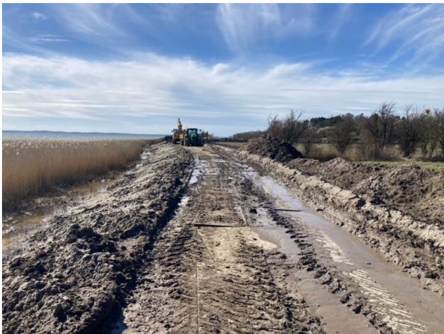
Arbejde med at forhøje diget ved Frederiksværk 2023. Foto Privat
