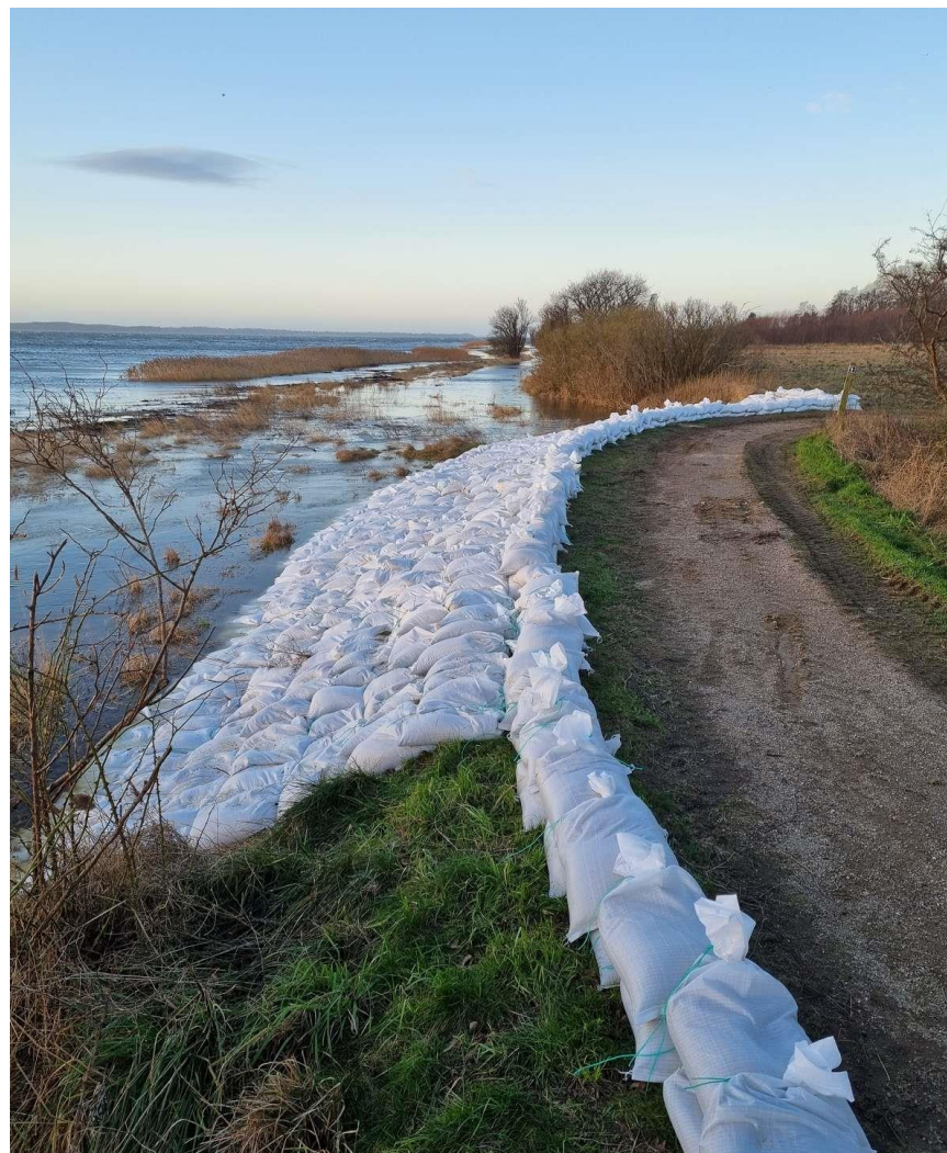
Sikring af dige i forbindelse med varslet stormflod – Malik. Foto privat
